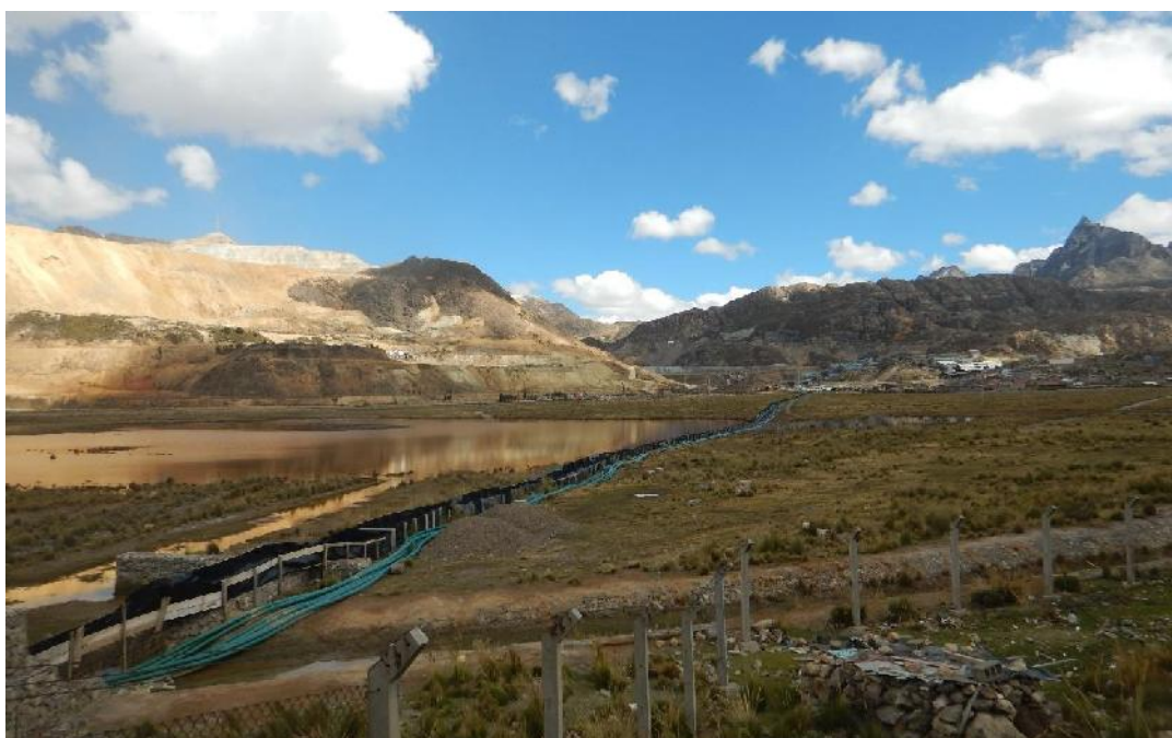
Fotografía 3.3.5.30: Antigua laguna Morococha, hoy rellena con excedentes mineros (TMORO).
