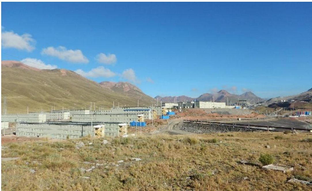
Fotografía 3.3.5.50: Campamento Tunshuruco, al lado de la quebrada Rumichaca (RUMI).
